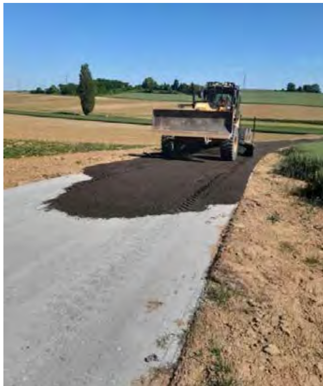
Pose d'une couche de roulement en concassé dans la descente du Pont du Kolbsenbach
