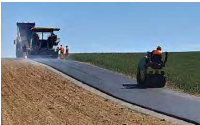
Pose d'enrobés aux abords des ateliers du SIVOM sur le chemin d'accès au pont du Leisbach
