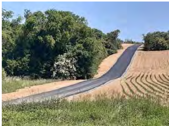
Pose d'enrobés sur le nouveau chemin longeant l'ACOS
